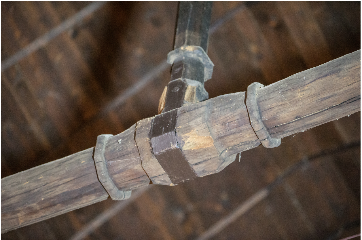
Un détail de la charpente du transept.
