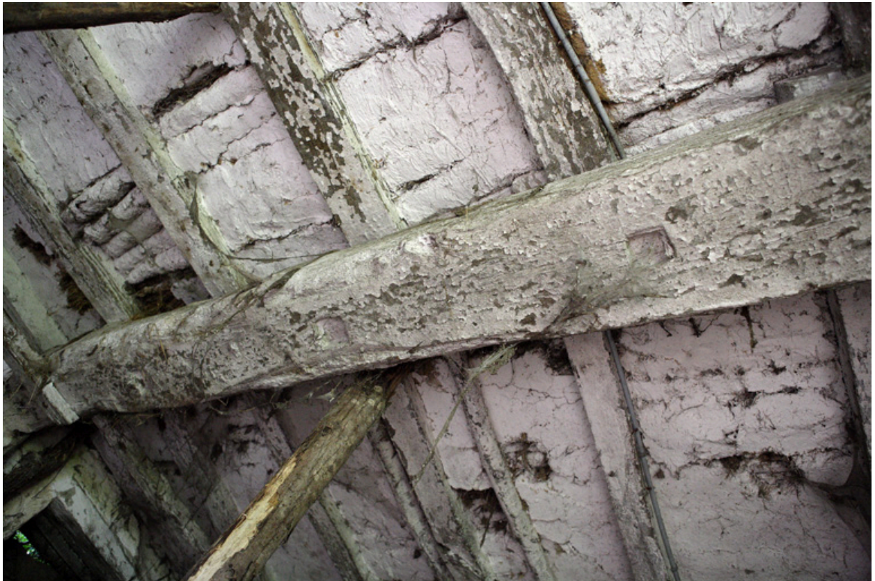
Bâtiment est. Métairie (?). Détail du plancher.
