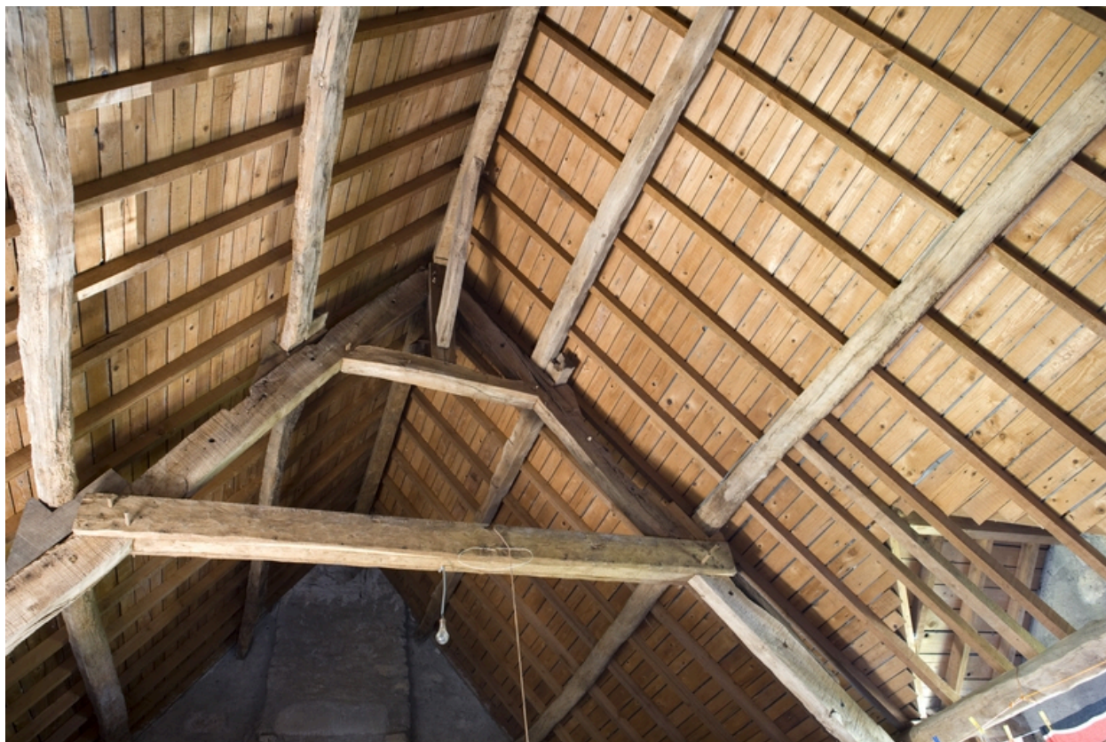
Vieux logis. Charpente.
