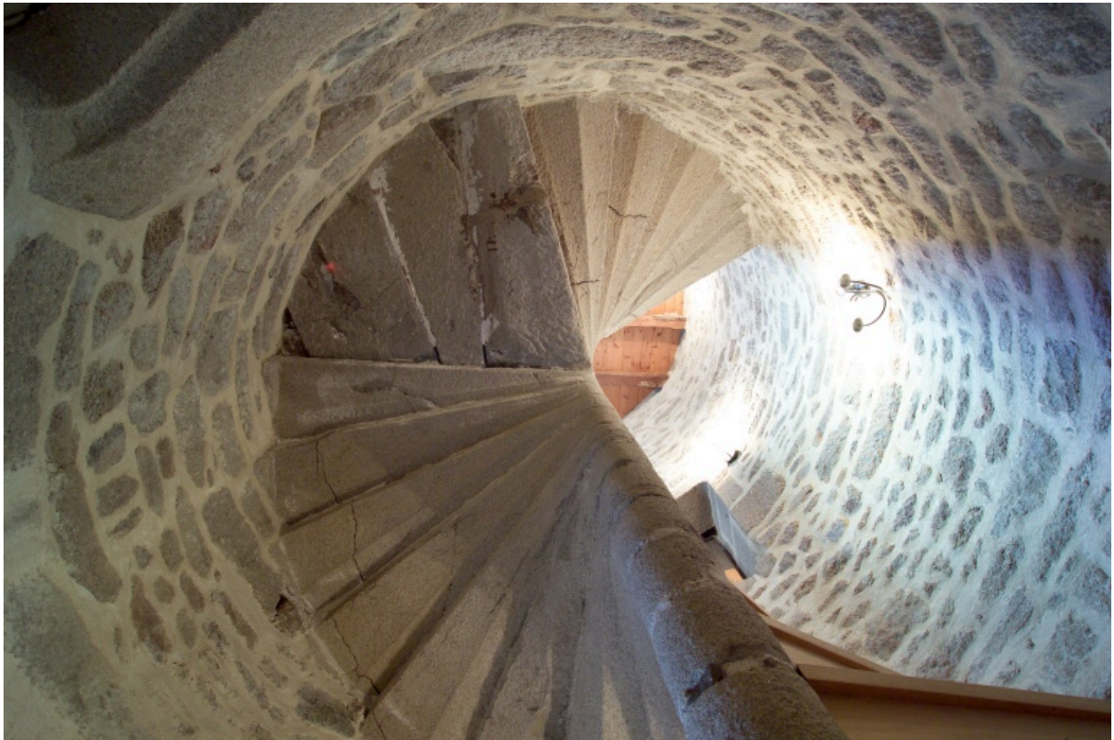
Escalier en vis.
