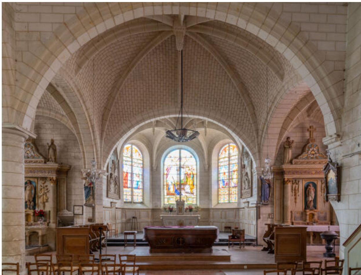
La croisée du transept et le chœur depuis la nef.
