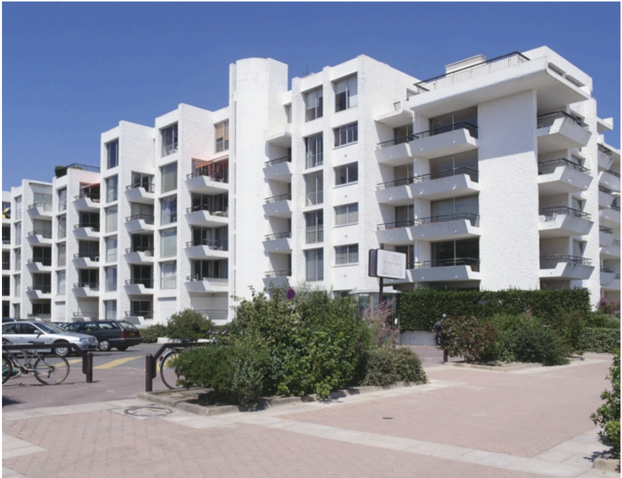
Façade ouest de l'immeuble à logements dit la Résidence du Golfe.
