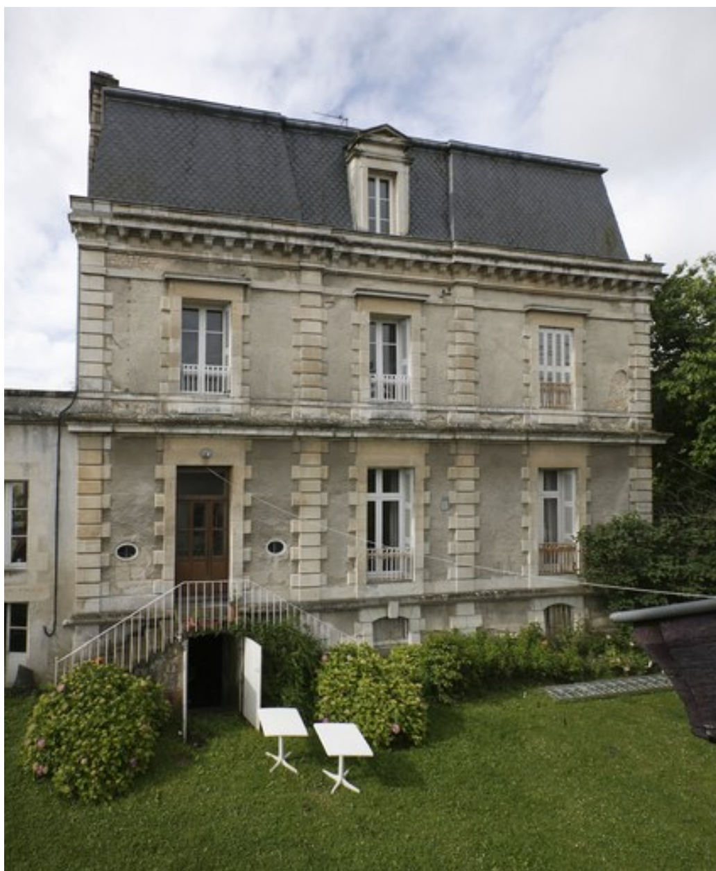
Vue de la façade arrière.
