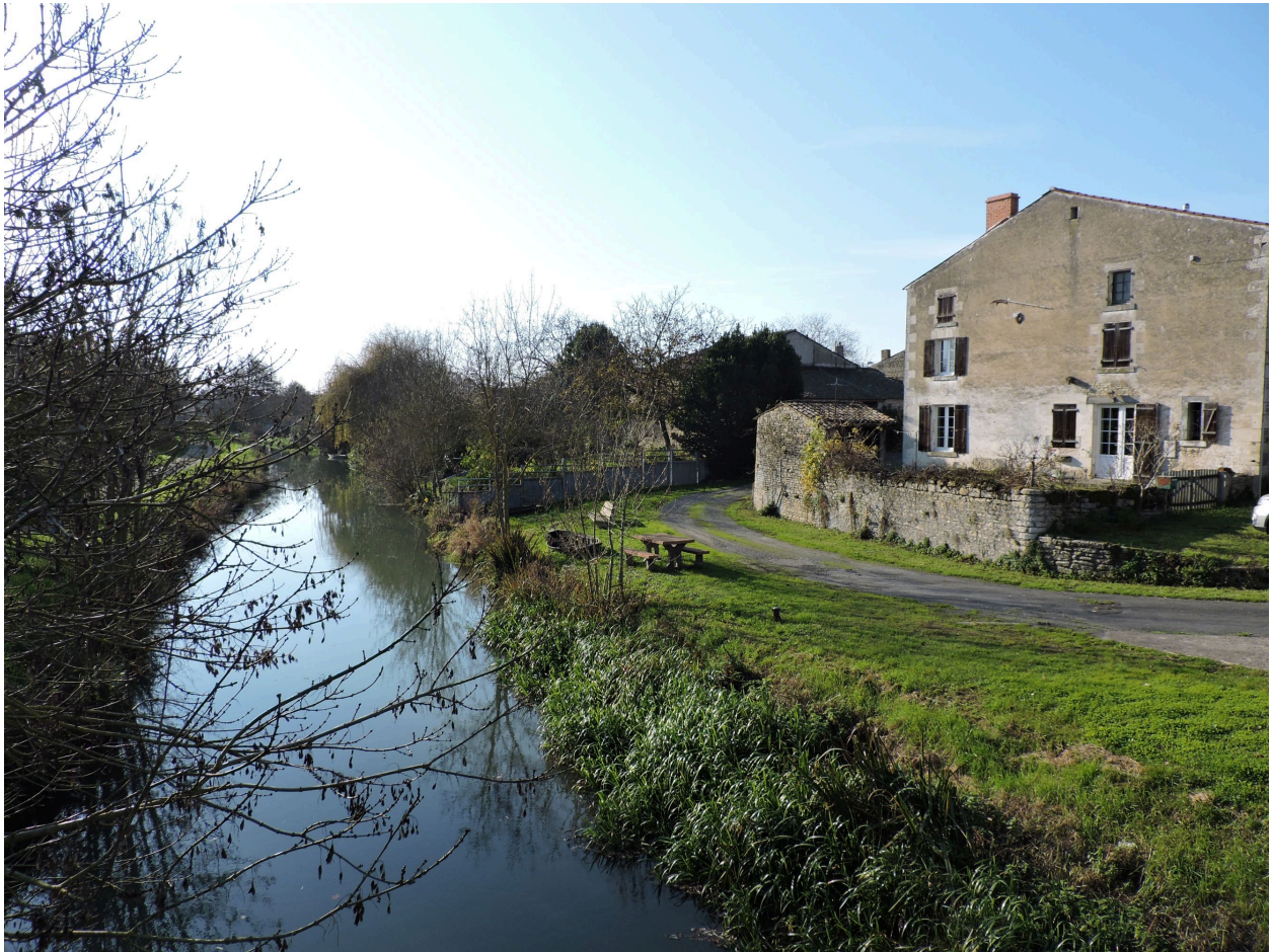
Le port, sur la rive droite de la Vieille Autize, vu depuis le pont au nord-est.
