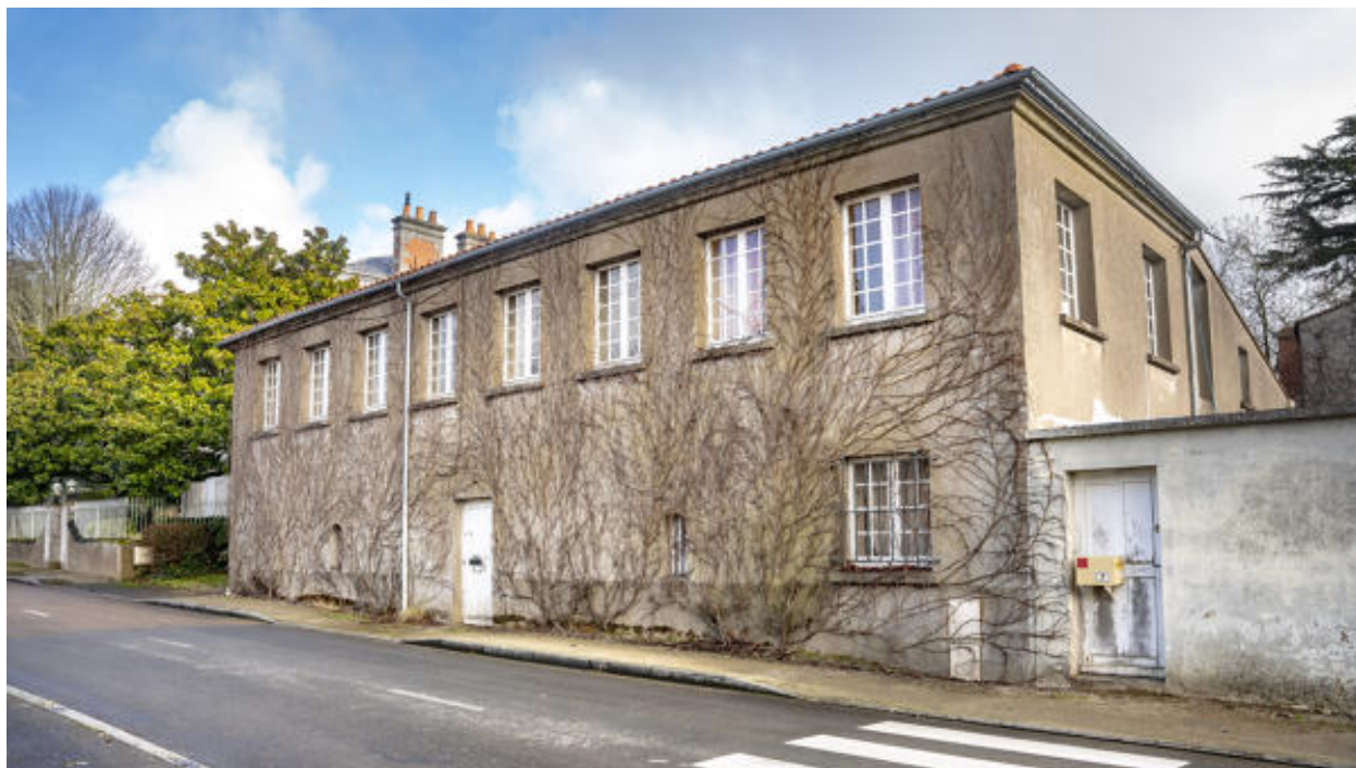
Bâtiment de bureaux, vue du sud.
