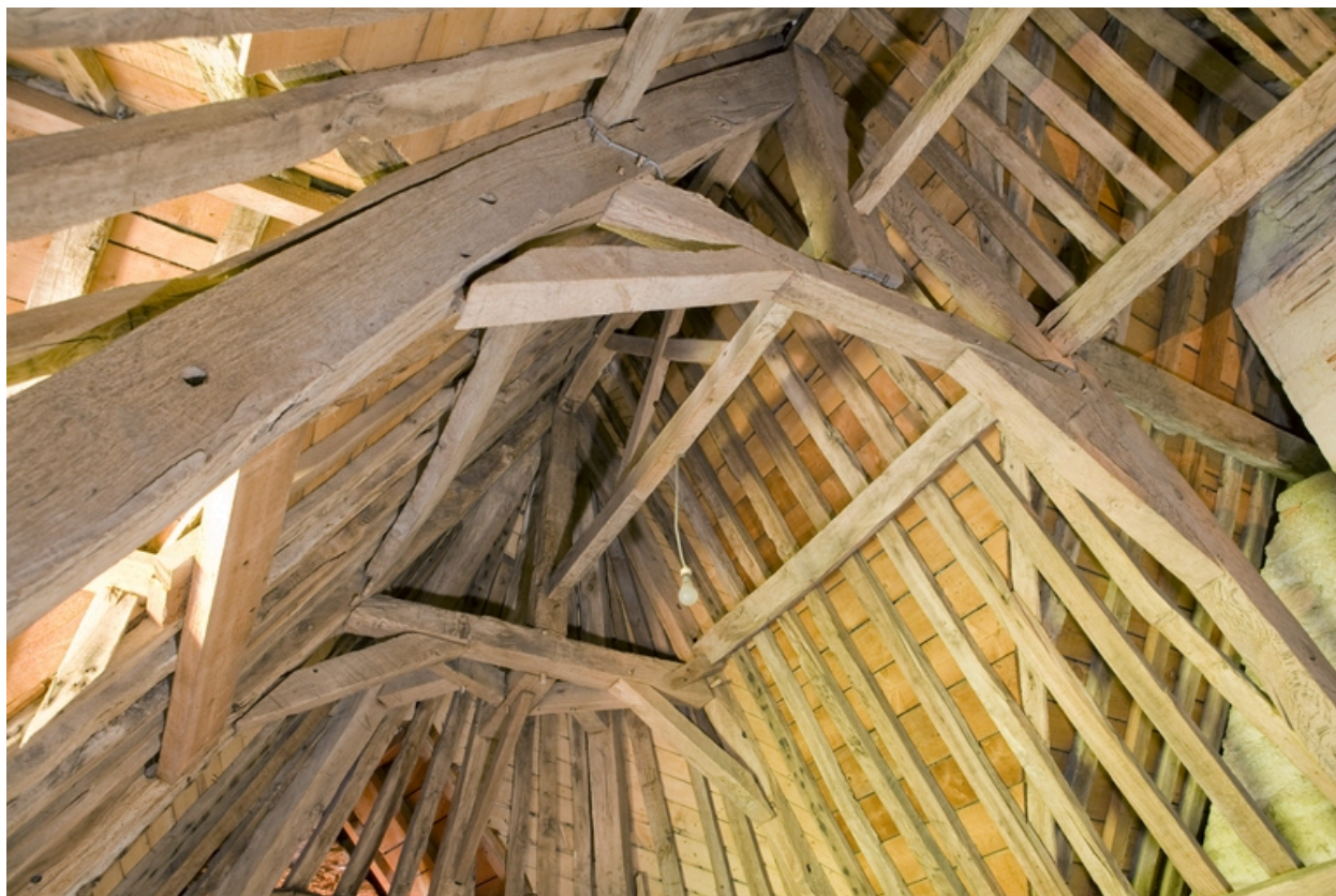
Pavillon. Salle nord. Charpente.
