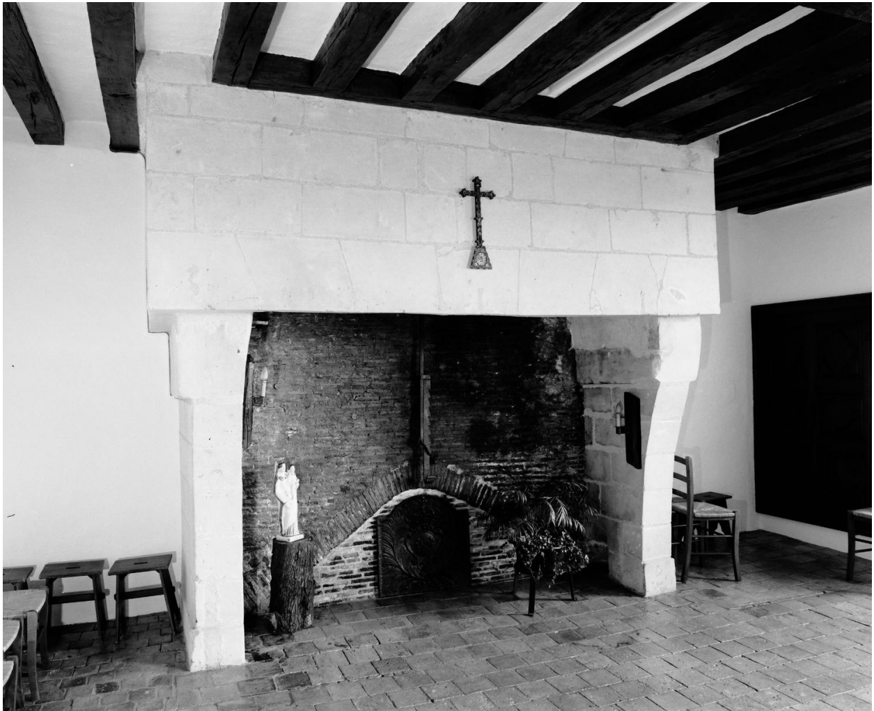
Aile sud du cloître, premier étage, actuelle salle de communauté, mur est : la cheminée.
