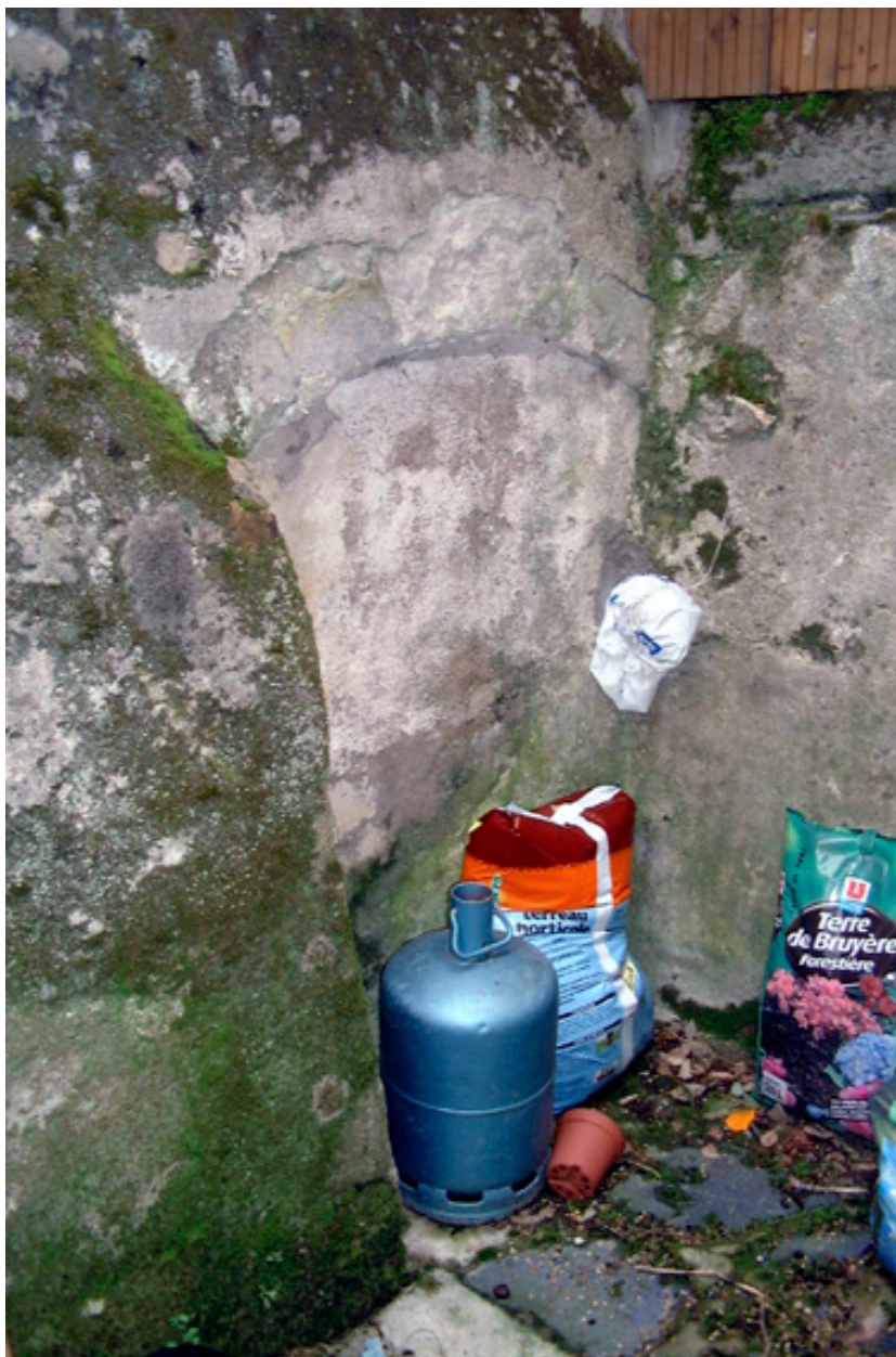
Détail d'une arcature bouchée sur le mur gouttereau nord.
