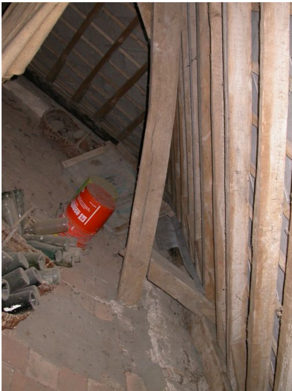
Le moulin, détail de la charpente.
