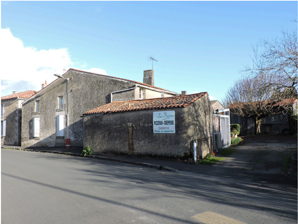
Le logis vu depuis l'ouest.
