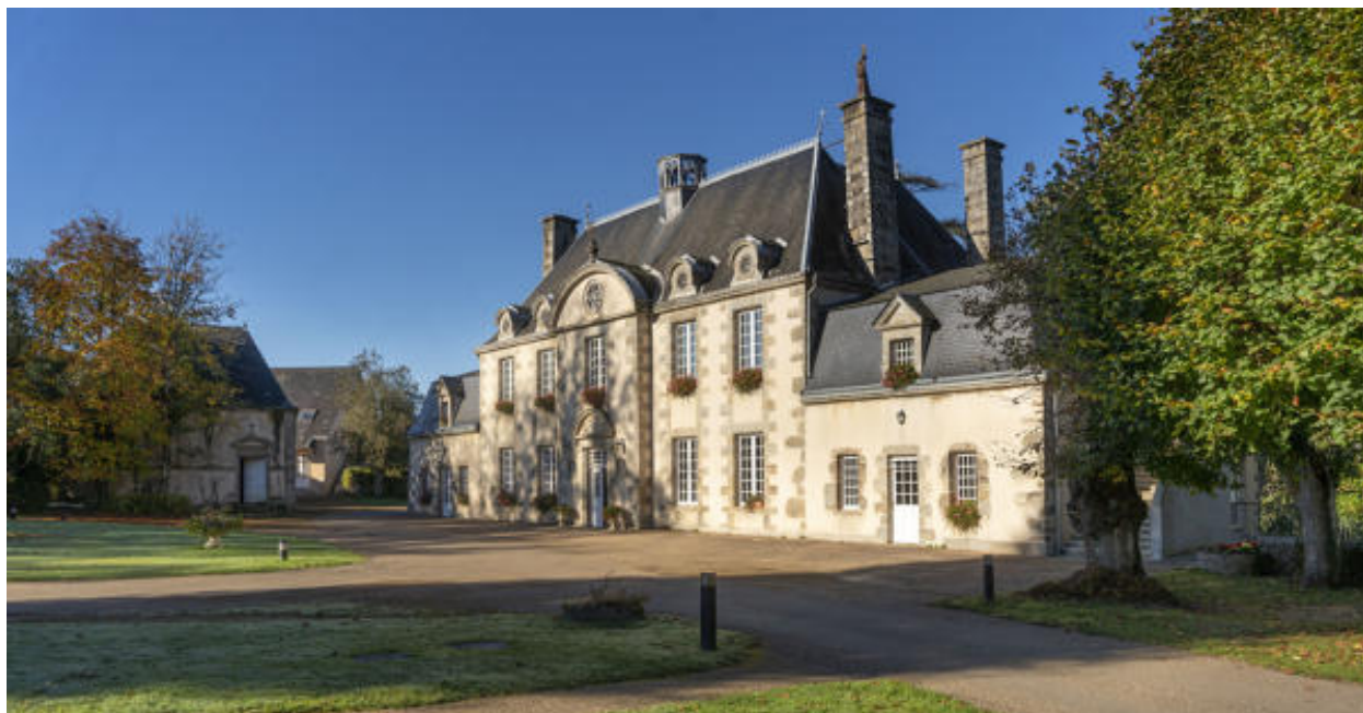
La façade antérieure du château.
