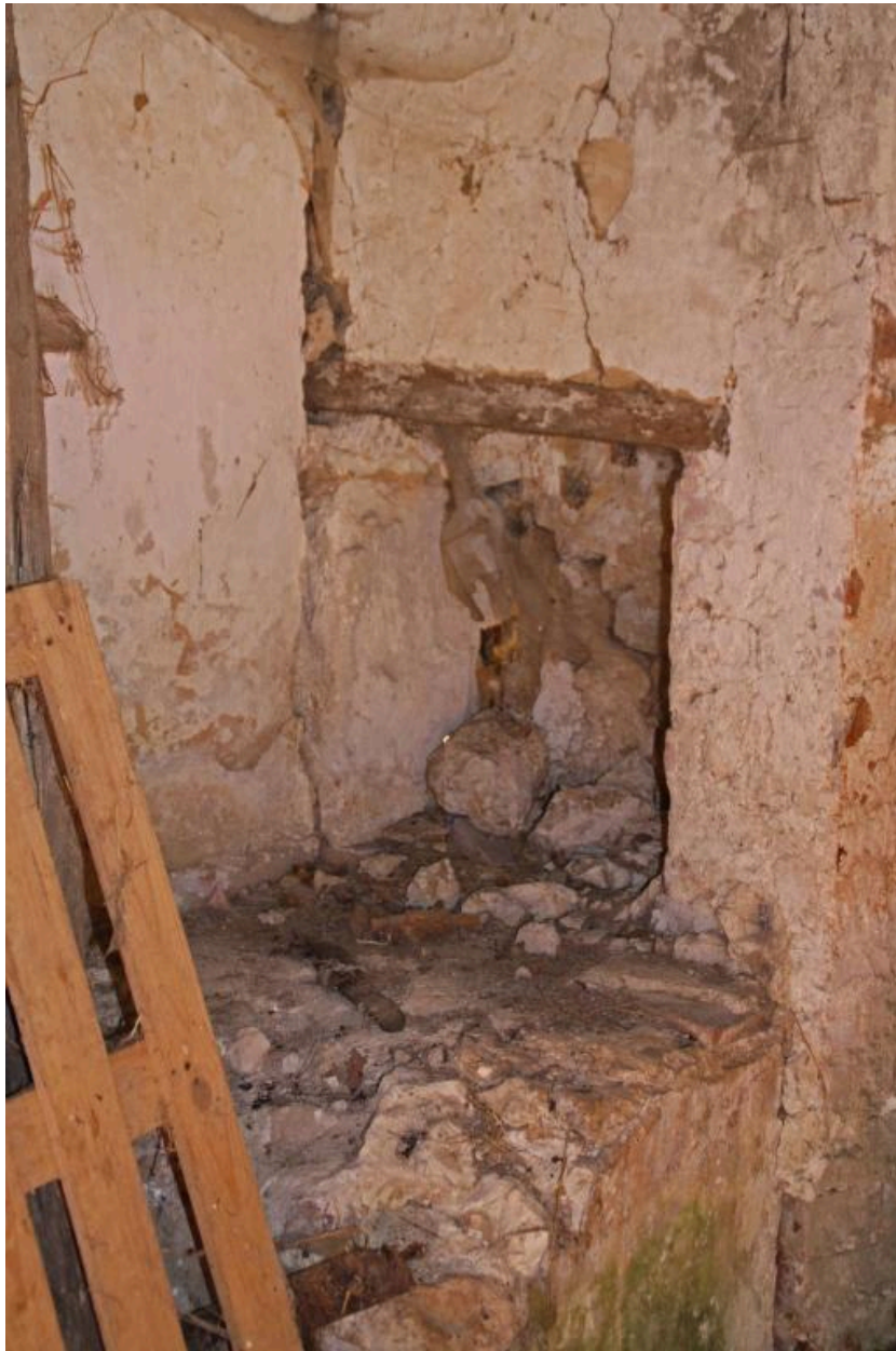
Maison 1 : niche murale à droite de la cheminée.
