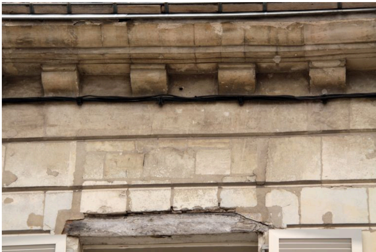
Pavillon d'entrée, détail : corniche à modillons.
