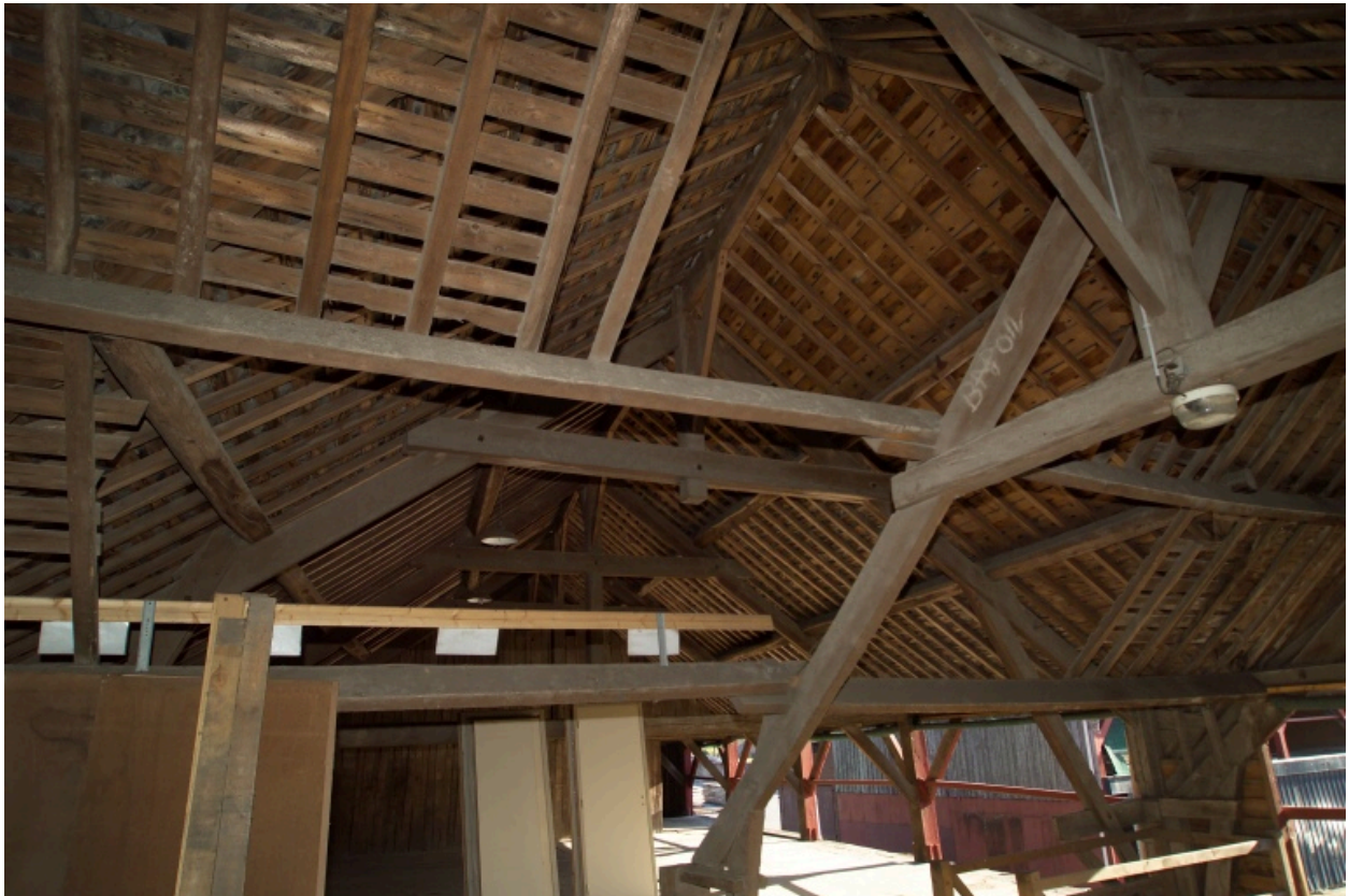
Cour d'entrée, détail de charpente d'un hangar.
