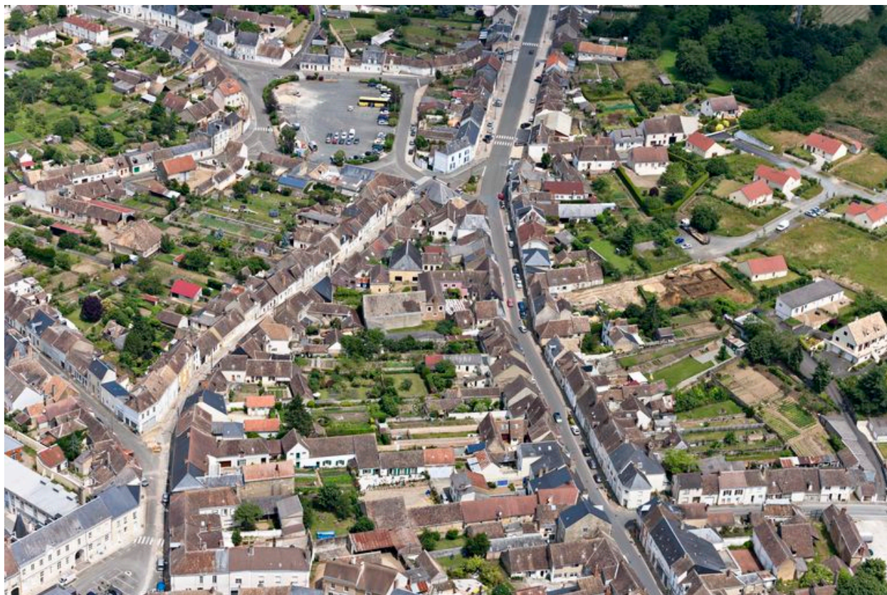
Vue aérienne de l'ilot cantonné par les rue du maréchal Joffre et Georges Clémenceau.
