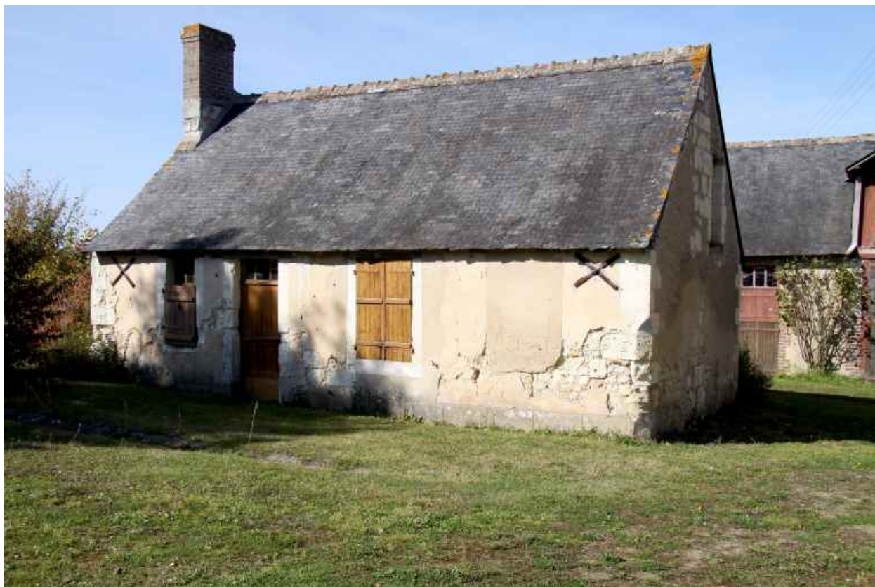
Maison 3 : façade antérieure.
