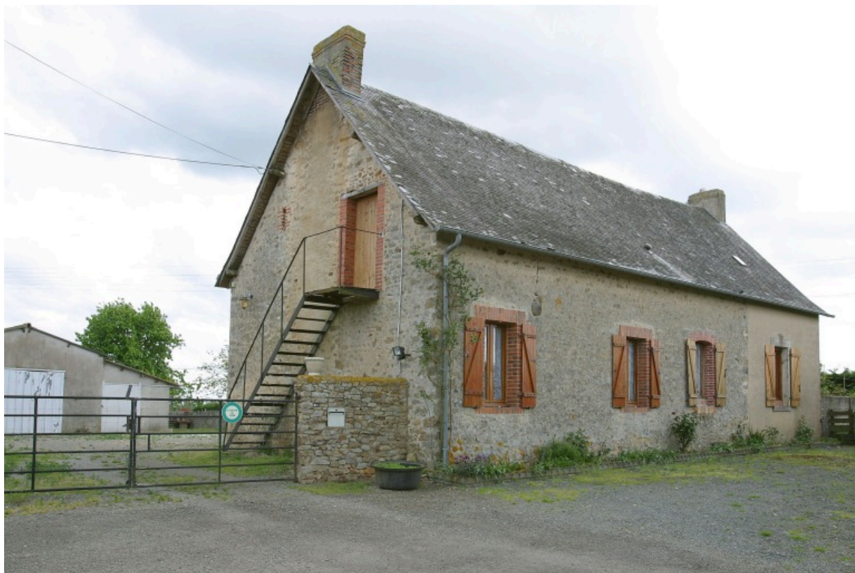
Le logis. Façade arrière.
