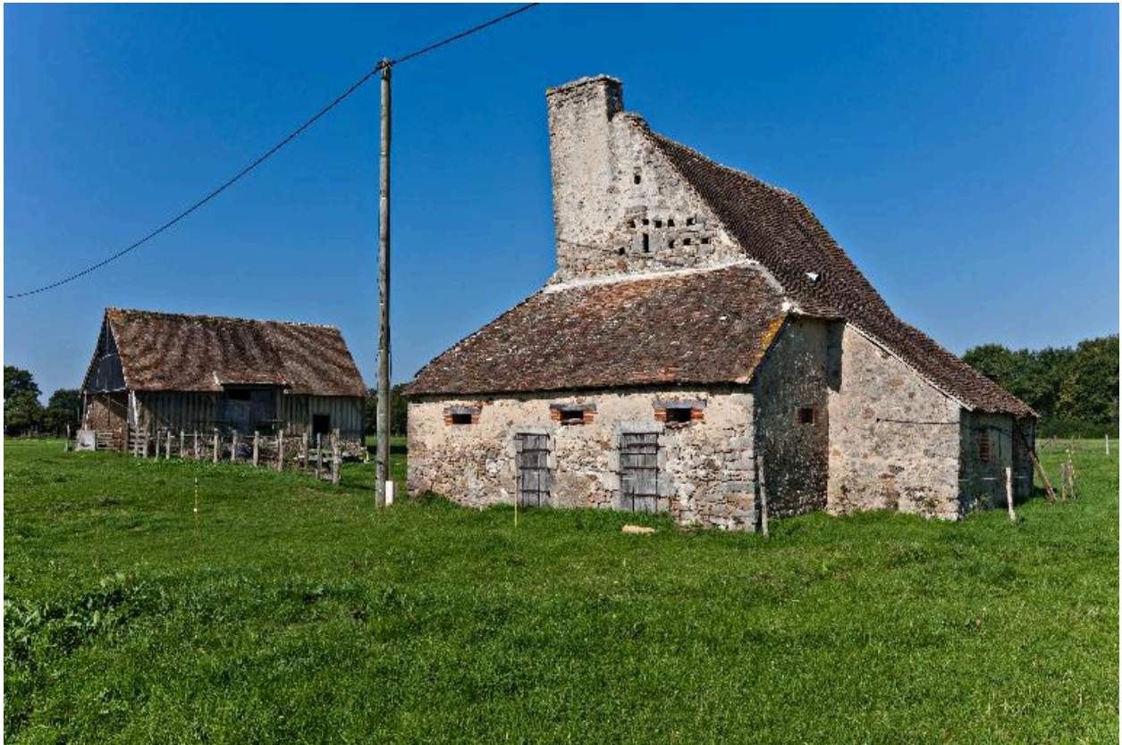
Vue générale depuis l'est.
