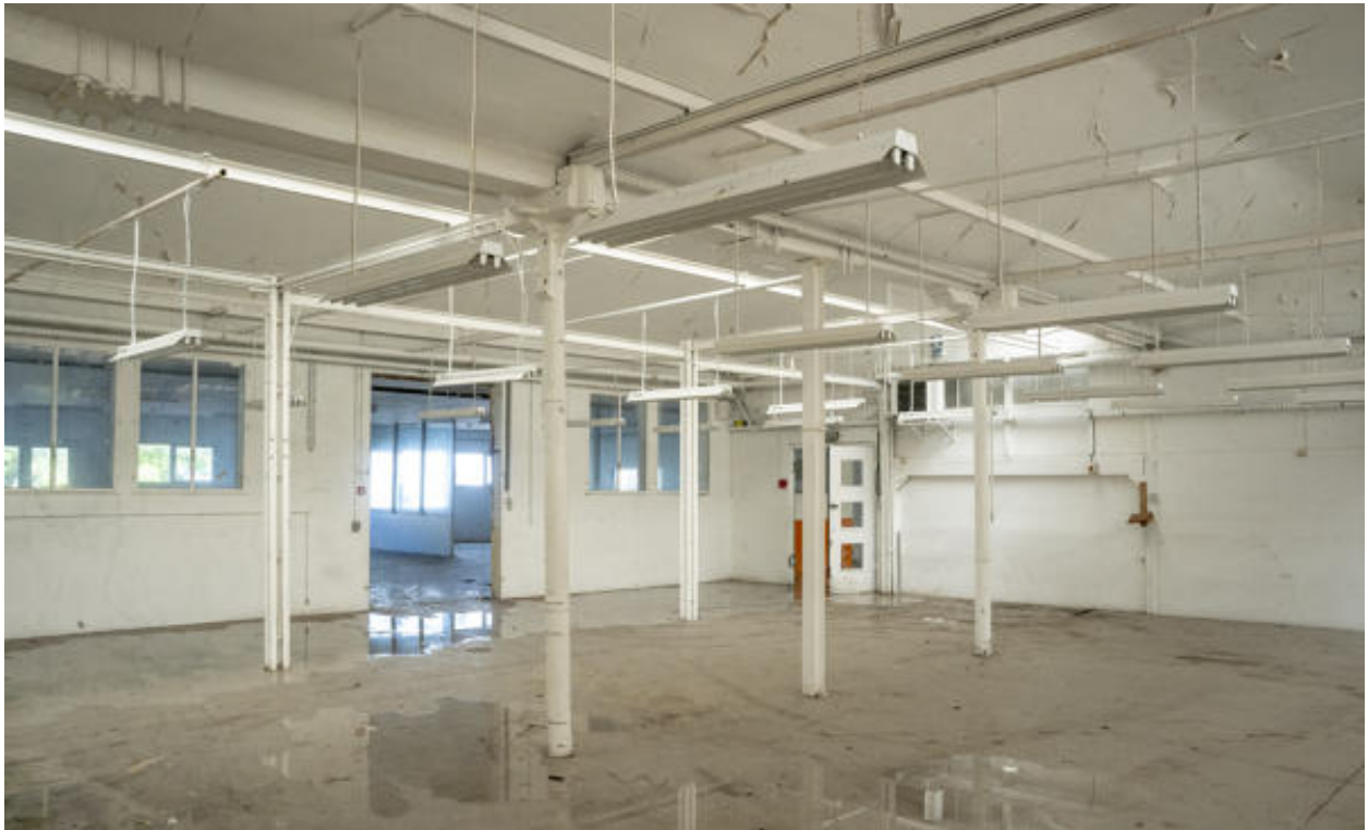
Vue intérieure des ateliers A
