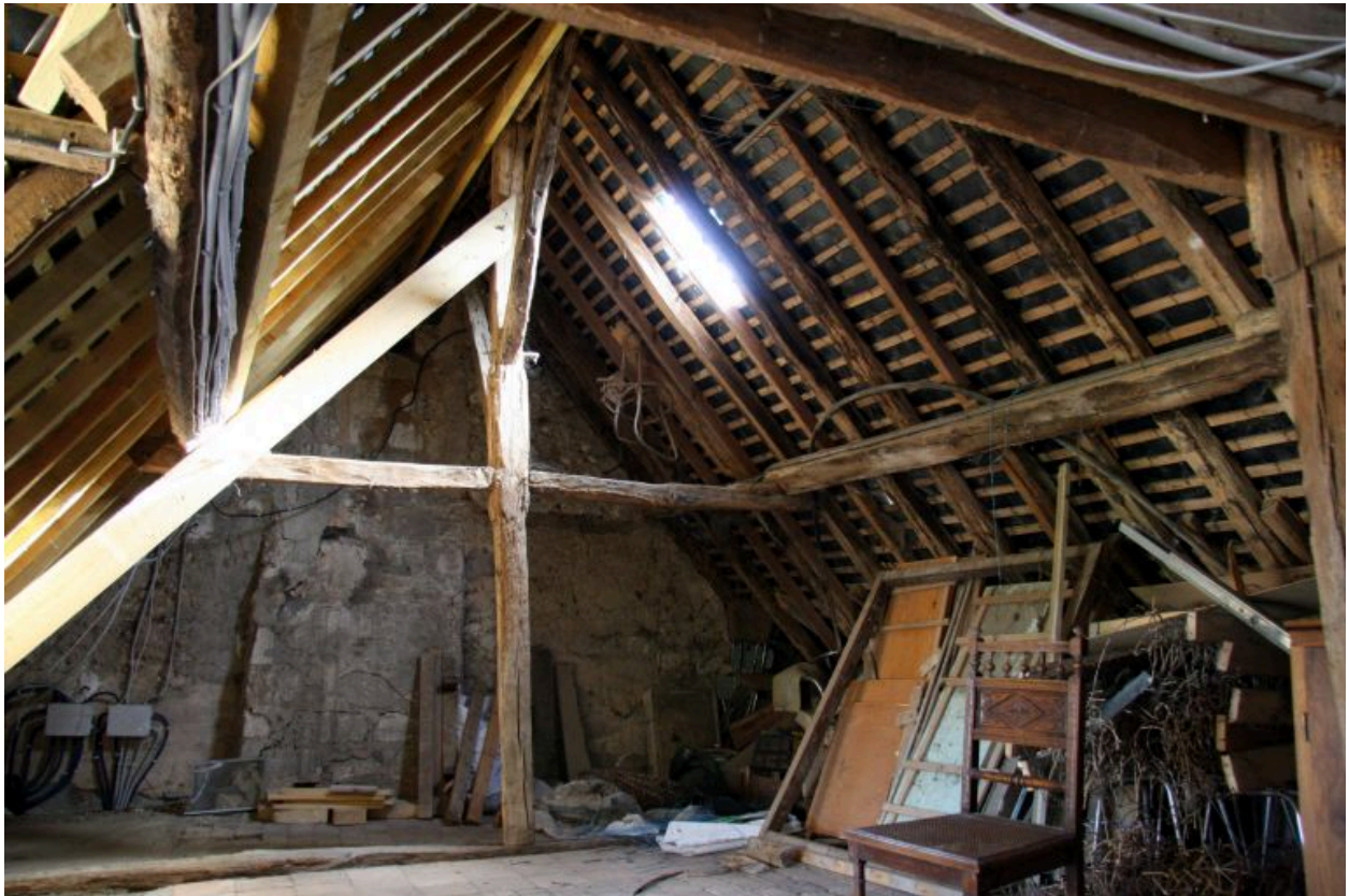
La maison : la charpente.
