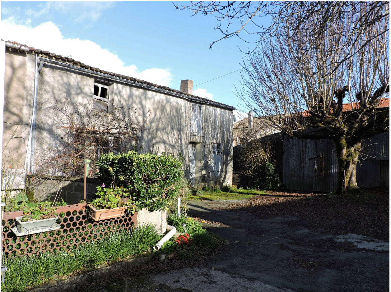
Le logis vu depuis l'ouest.
