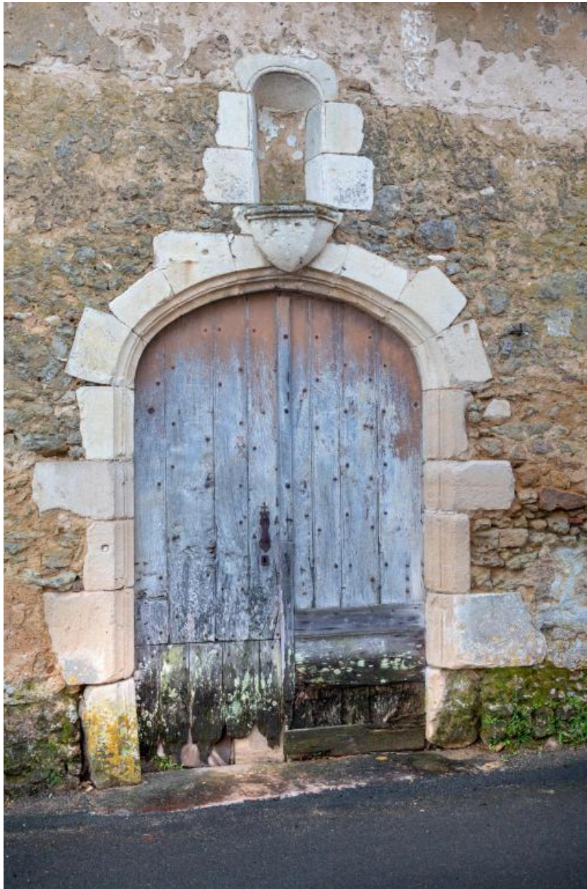
La porte de la chapelle, côté rue.
