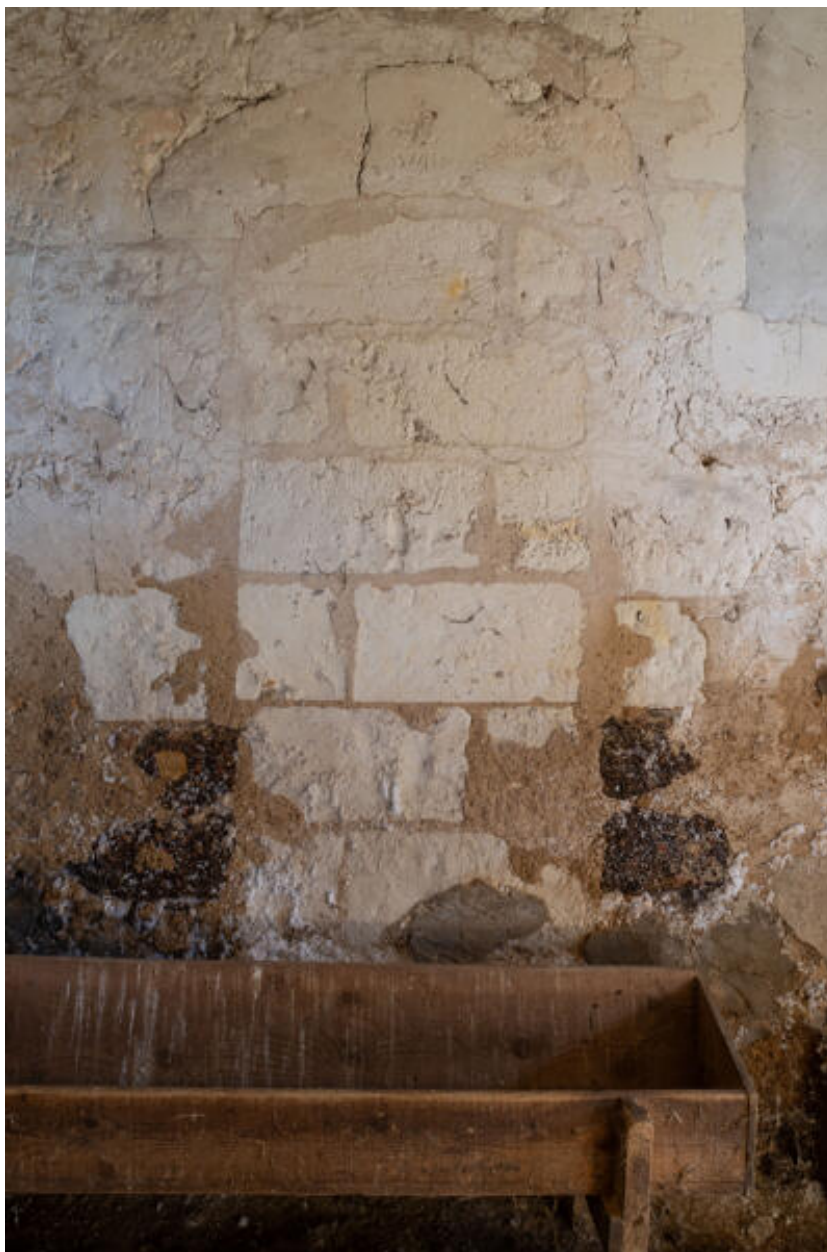
Grange-étable : ancienne porte avec date portée, 1741.
