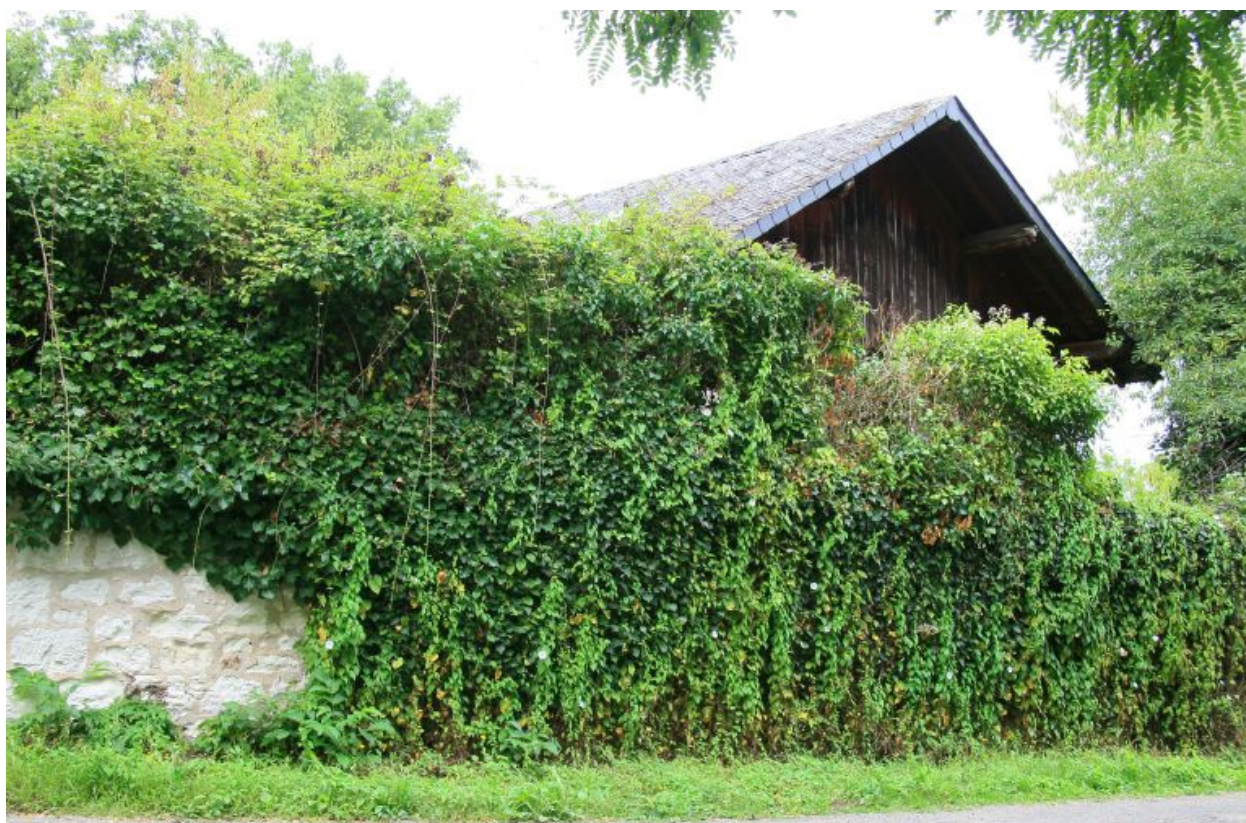
Bâtiment du jeu de boule de fort : pignon sur le chemin.
