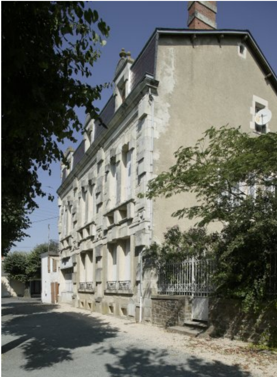
Maison 3, avenue de Verdun, au décor simplement épannelé.
