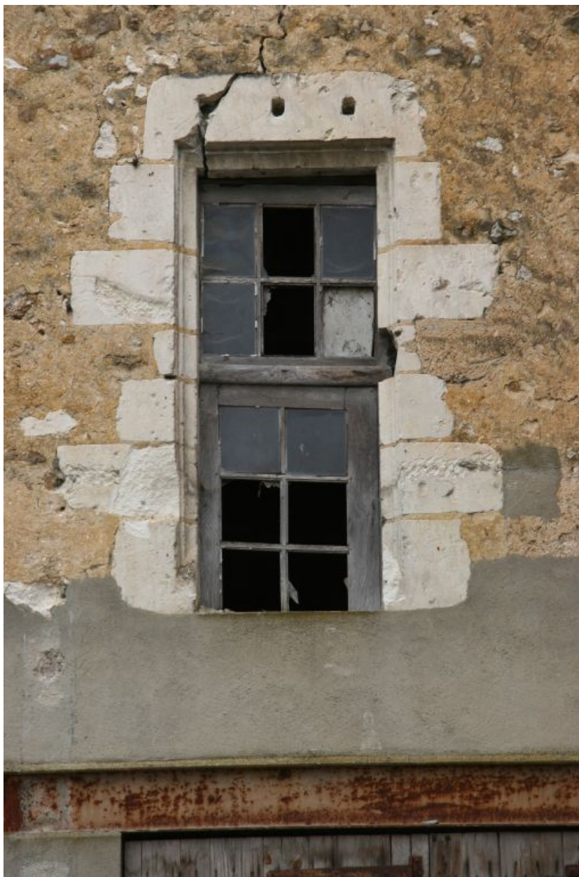
Pignon est, détail : demi-baie.
