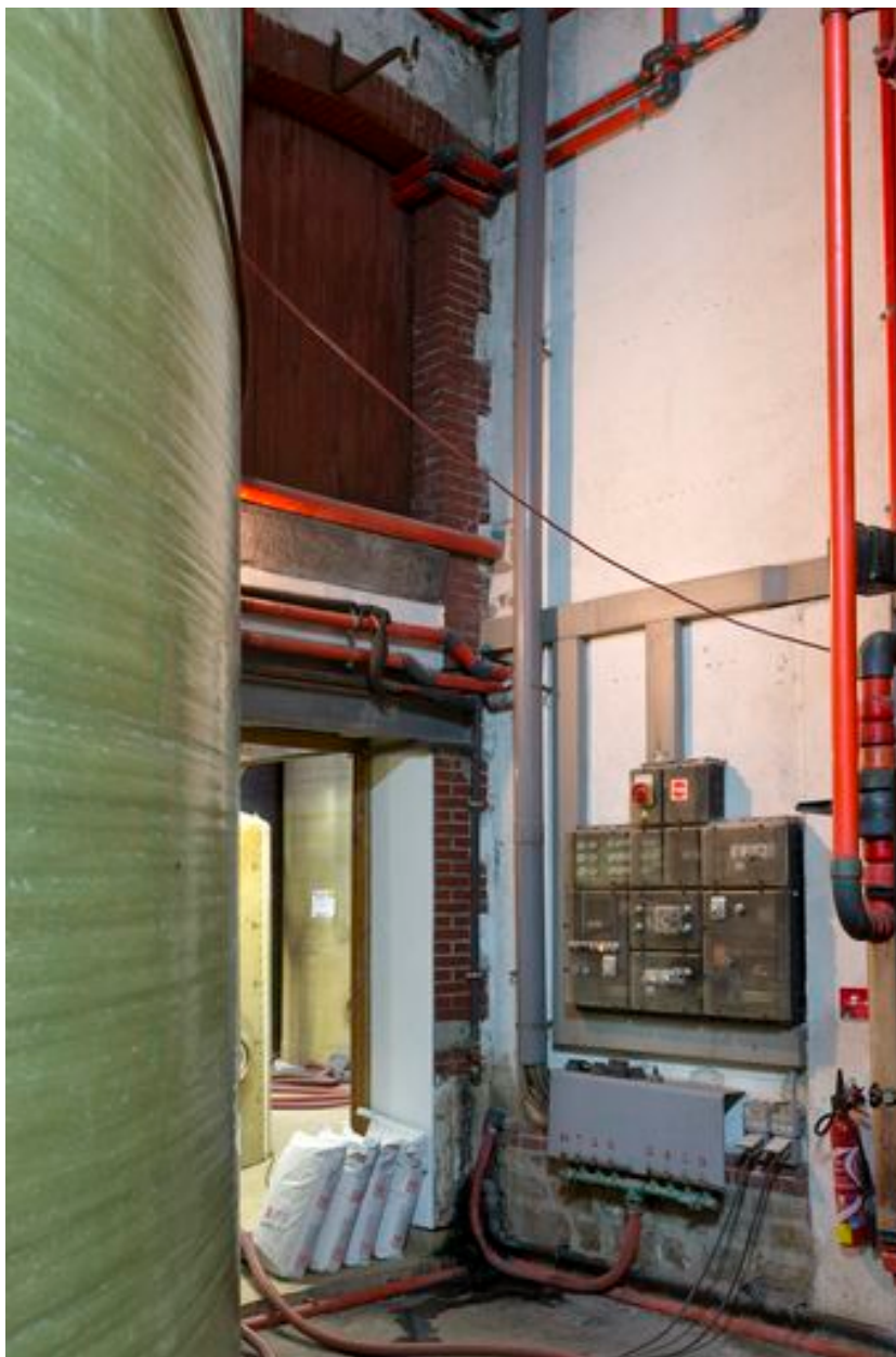
24 rue des Chantiers Crucy : façade d'origine donnant anciennement sur une cour aujourd'hui couverte.
