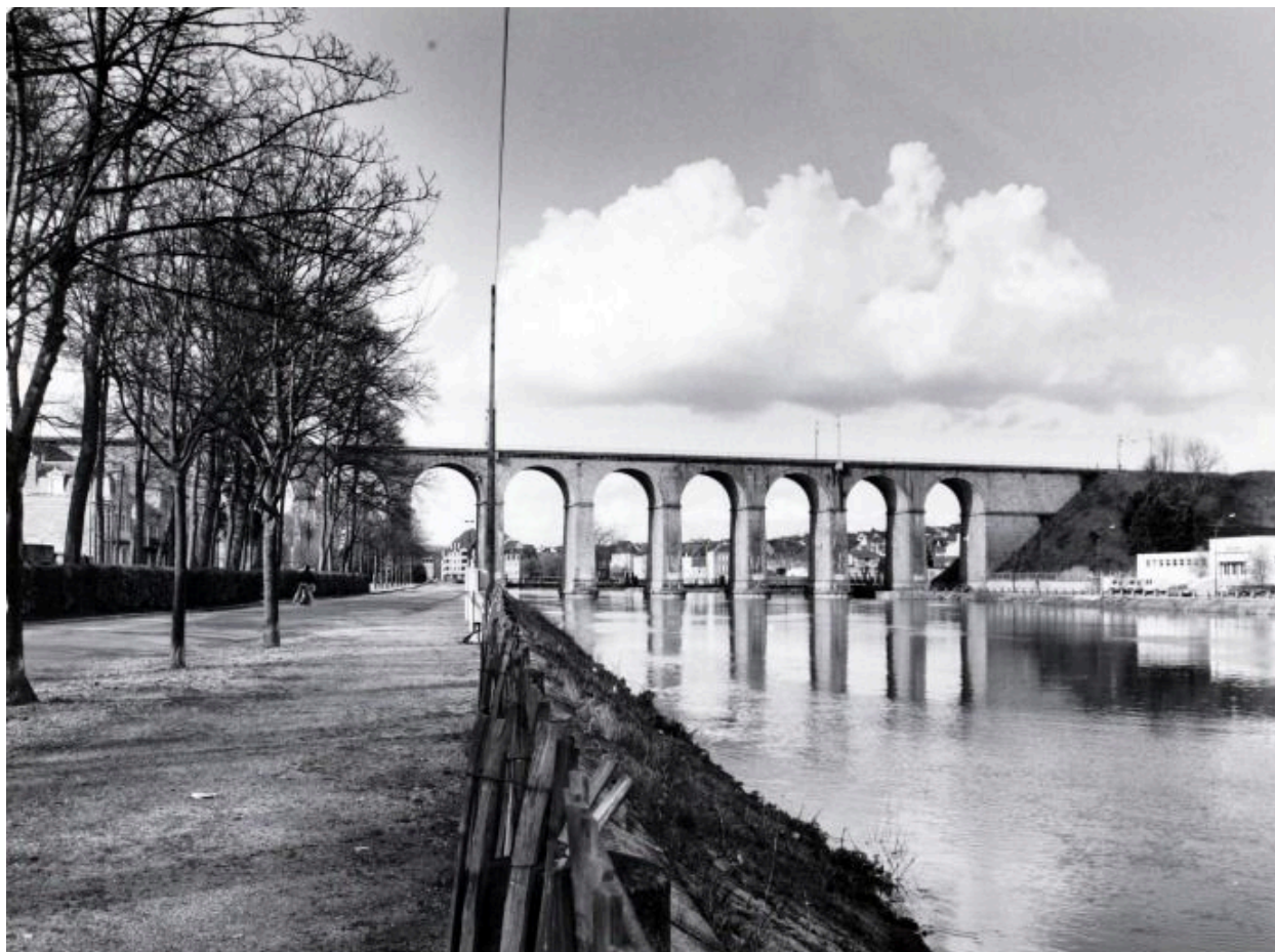
Vue d'ensemble du viaduc depuis la rive droite, en aval.
