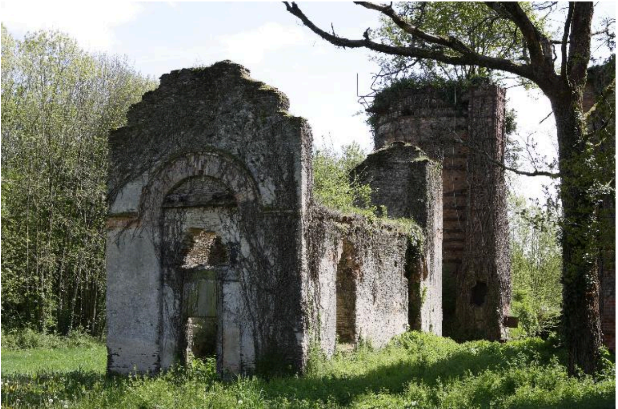
Bâtiment des machines à vapeur.
