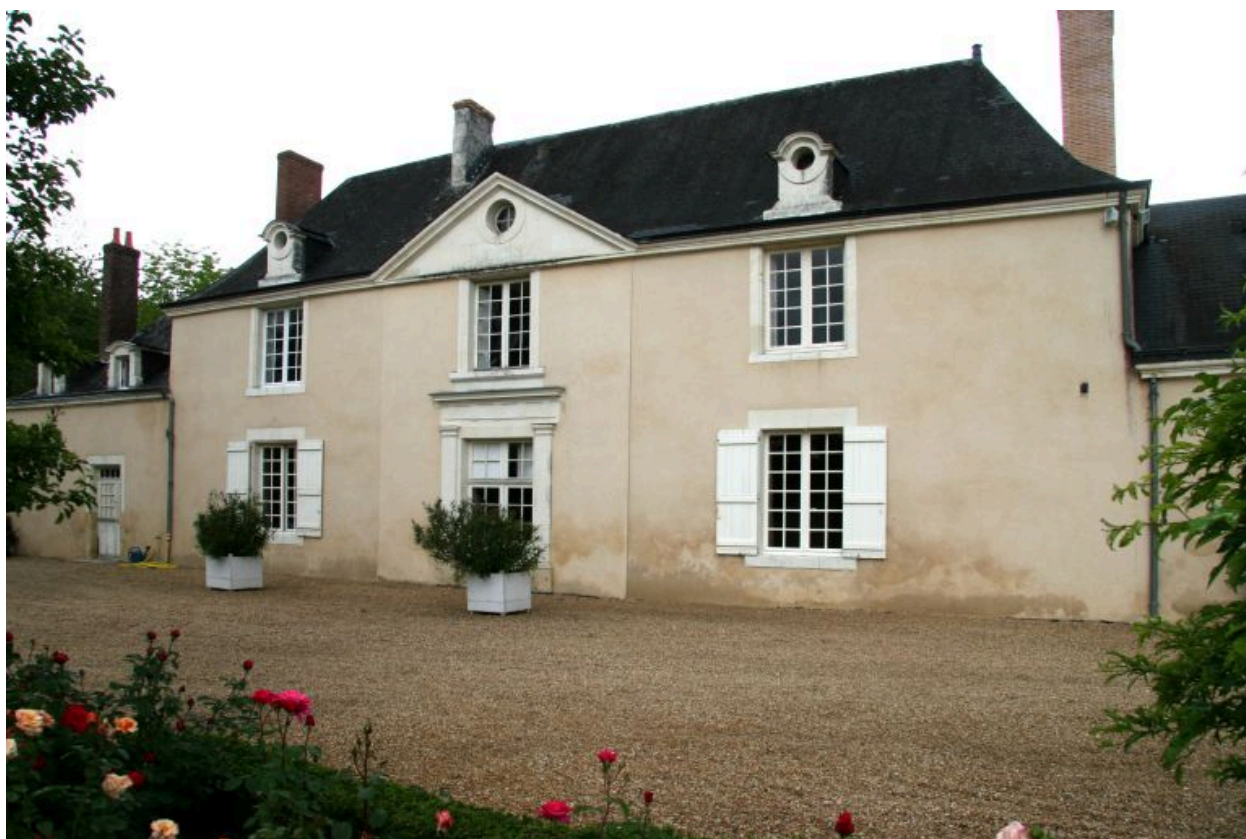
Le logis : façade antérieure.
