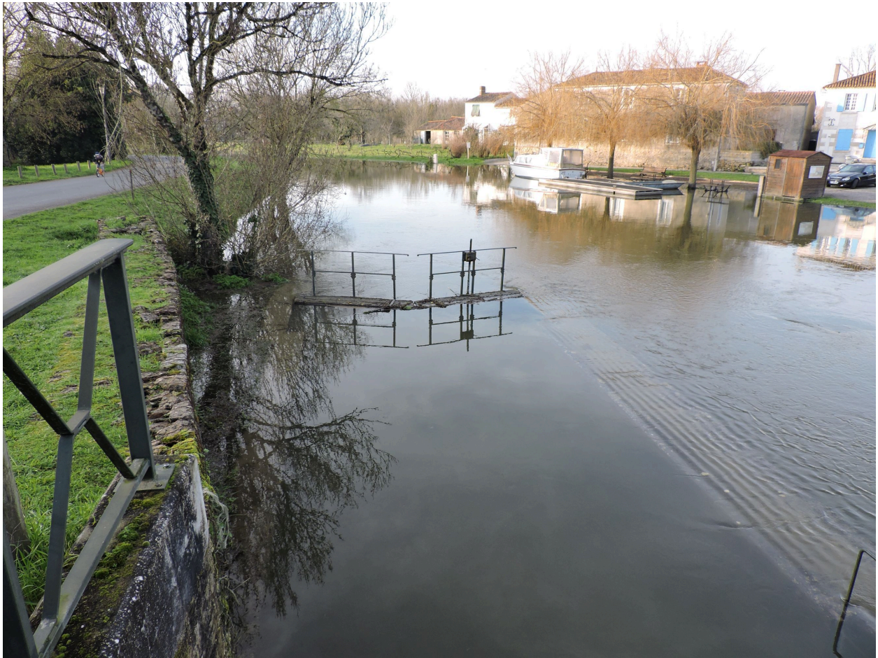
L'écluse submergée par l'inondation.
