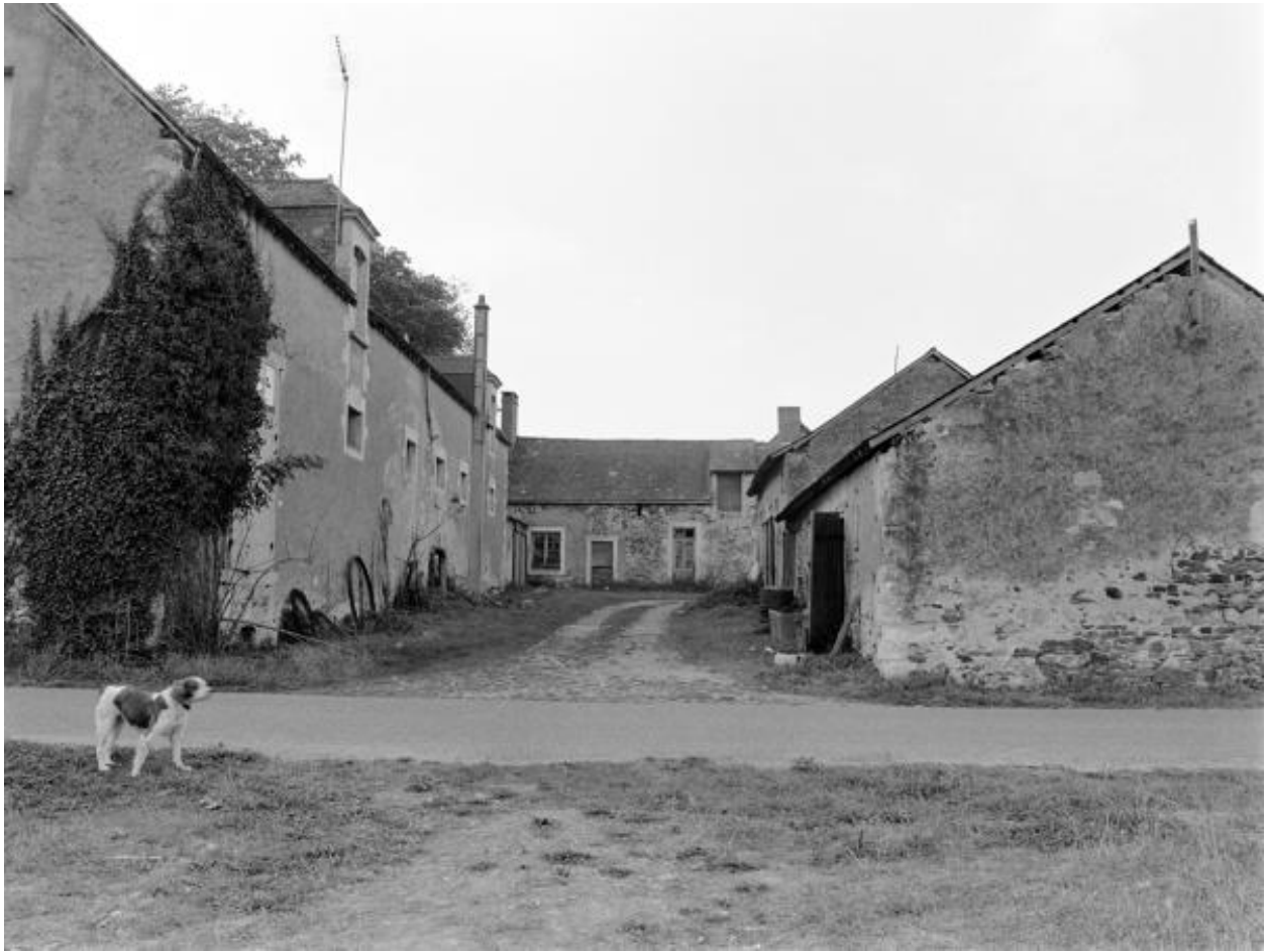
Ferme depuis la rue, écuries à gauche, logement au fond, étables et cellier à droite, 1985.
