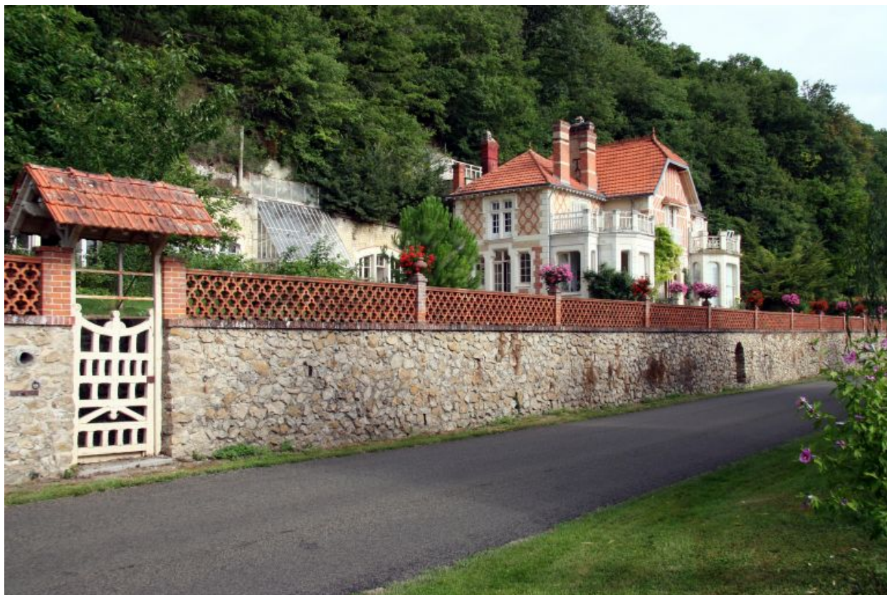
Vue de volume prise de l'aval.
