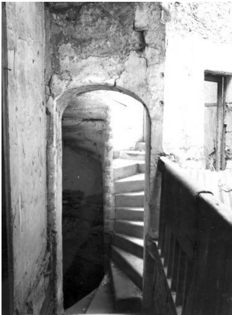
Escalier, depuis la galerie.
