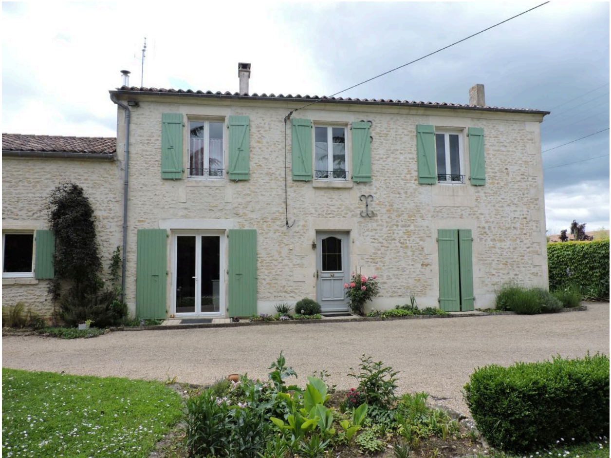
Le logis vu depuis l'est.
