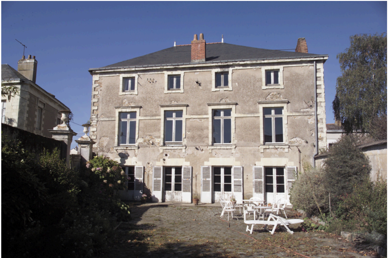
La façade postérieure.
