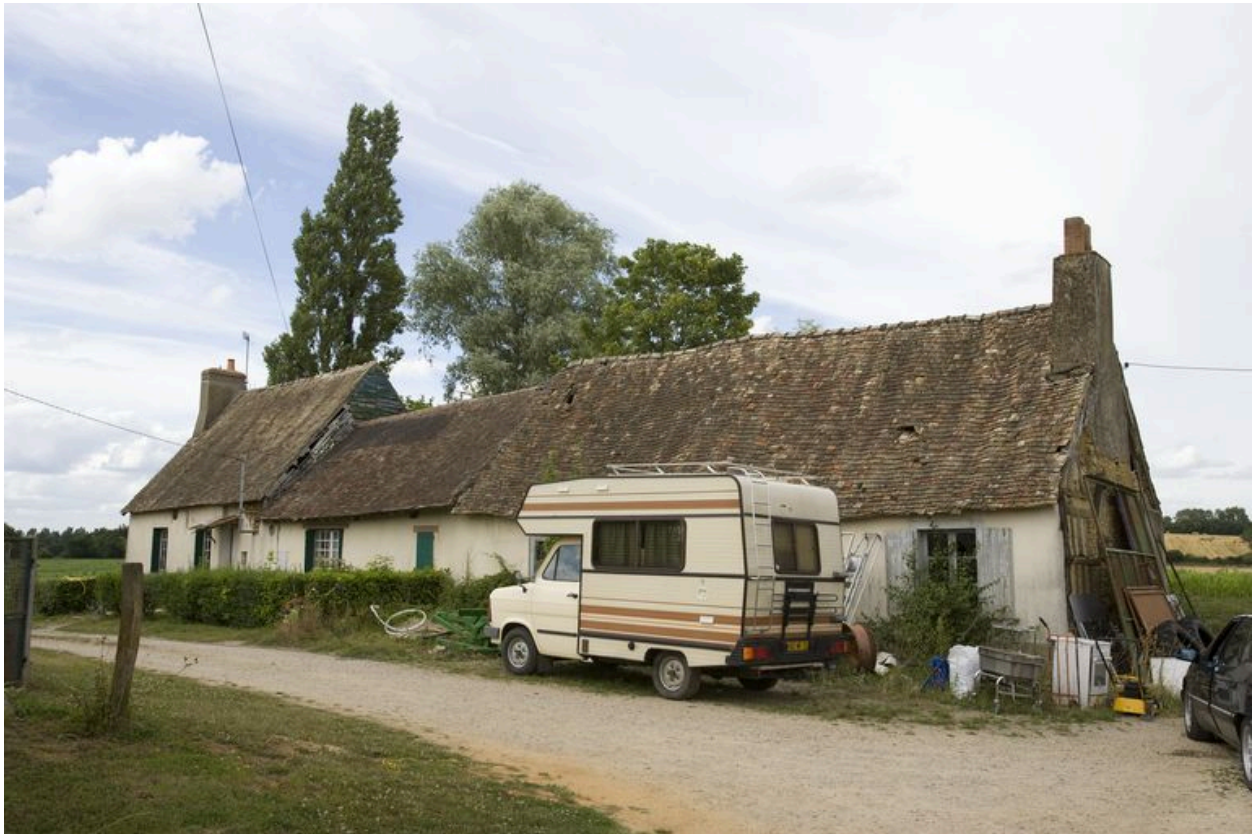
Maisons 2 et 3, vue générale depuis le sud.
