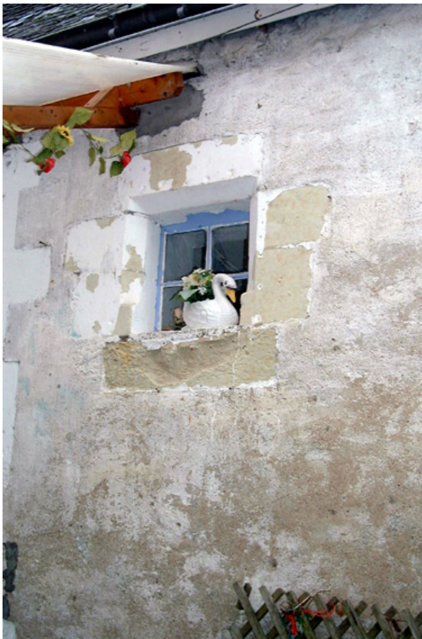
Détail d'un jour sur le mur gouttereau nord.
