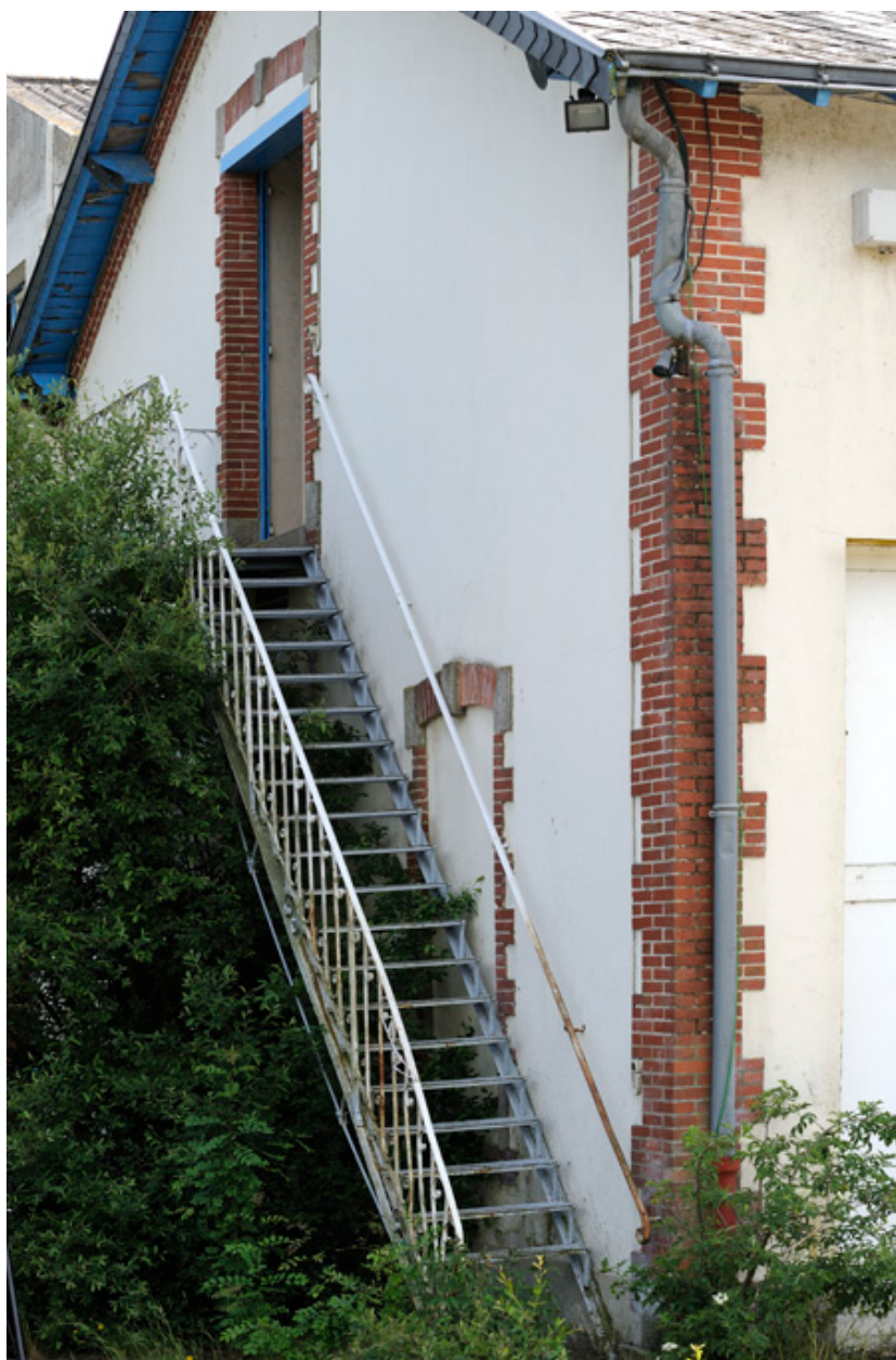
Laiterie-fromagerie Gallais : détail de l'escalier extérieur du bâtiment datant de 1905.
