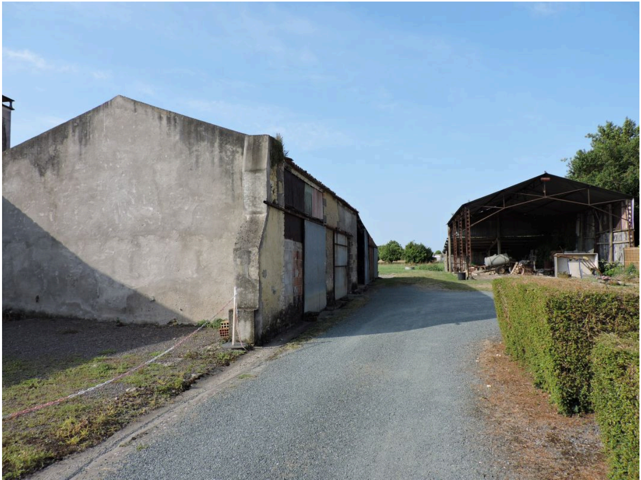
La grange-étable et le hangar métallique vus depuis le nord.
