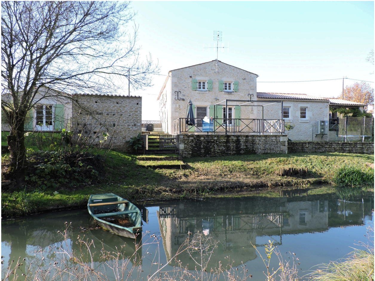
L'ancienne ferme et sa cale à bateau au bord de la rivière, vues depuis l'est.
