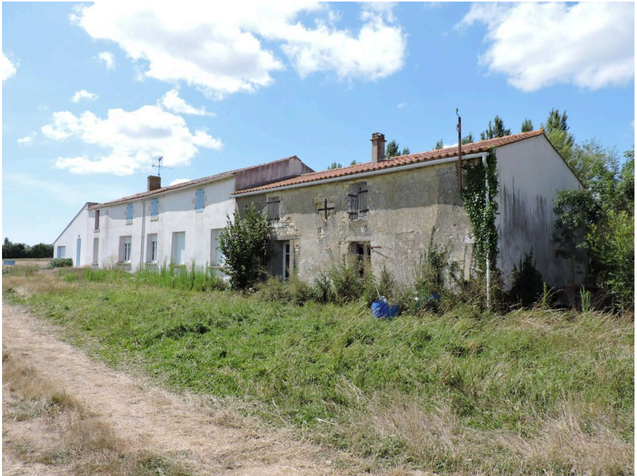
Le logis, à gauche, et l'ancien logement, à droite, vus depuis le sud-est.
