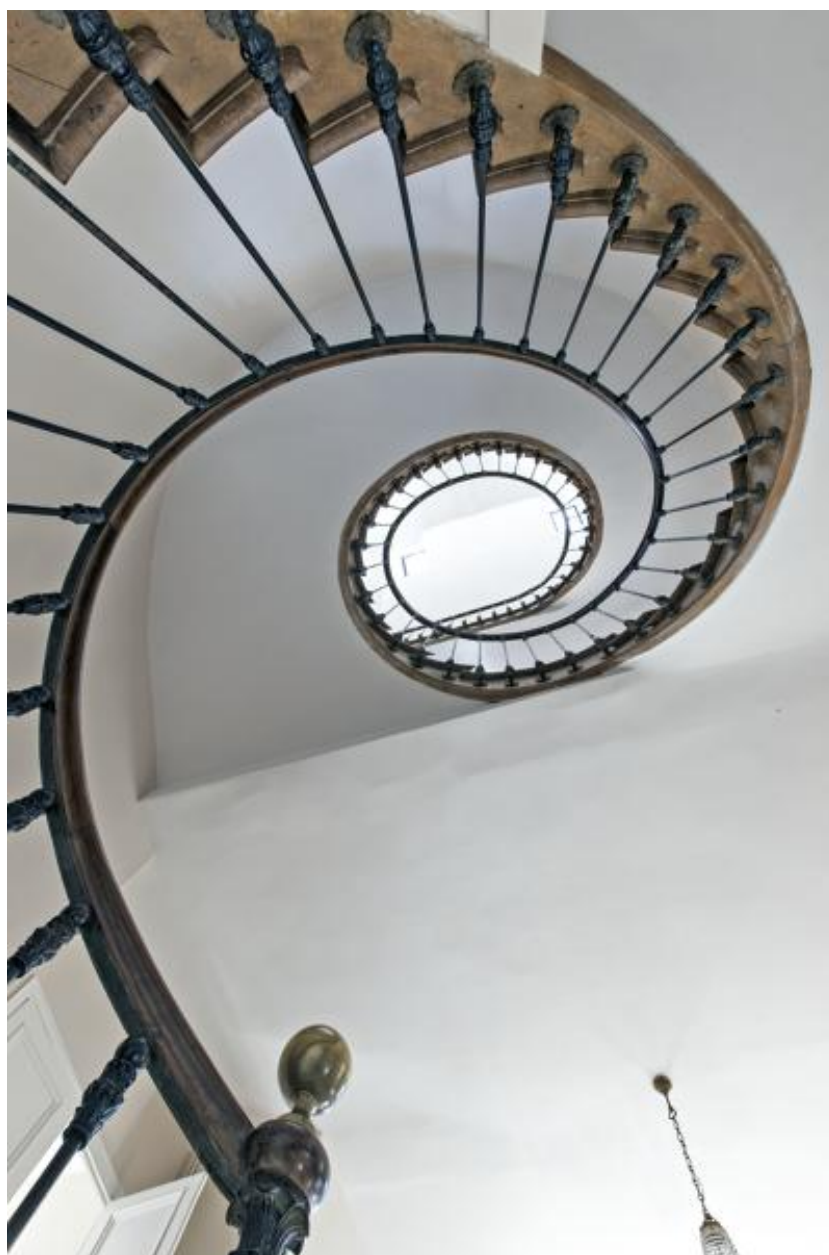
Escalier principal, vu du dessous.
