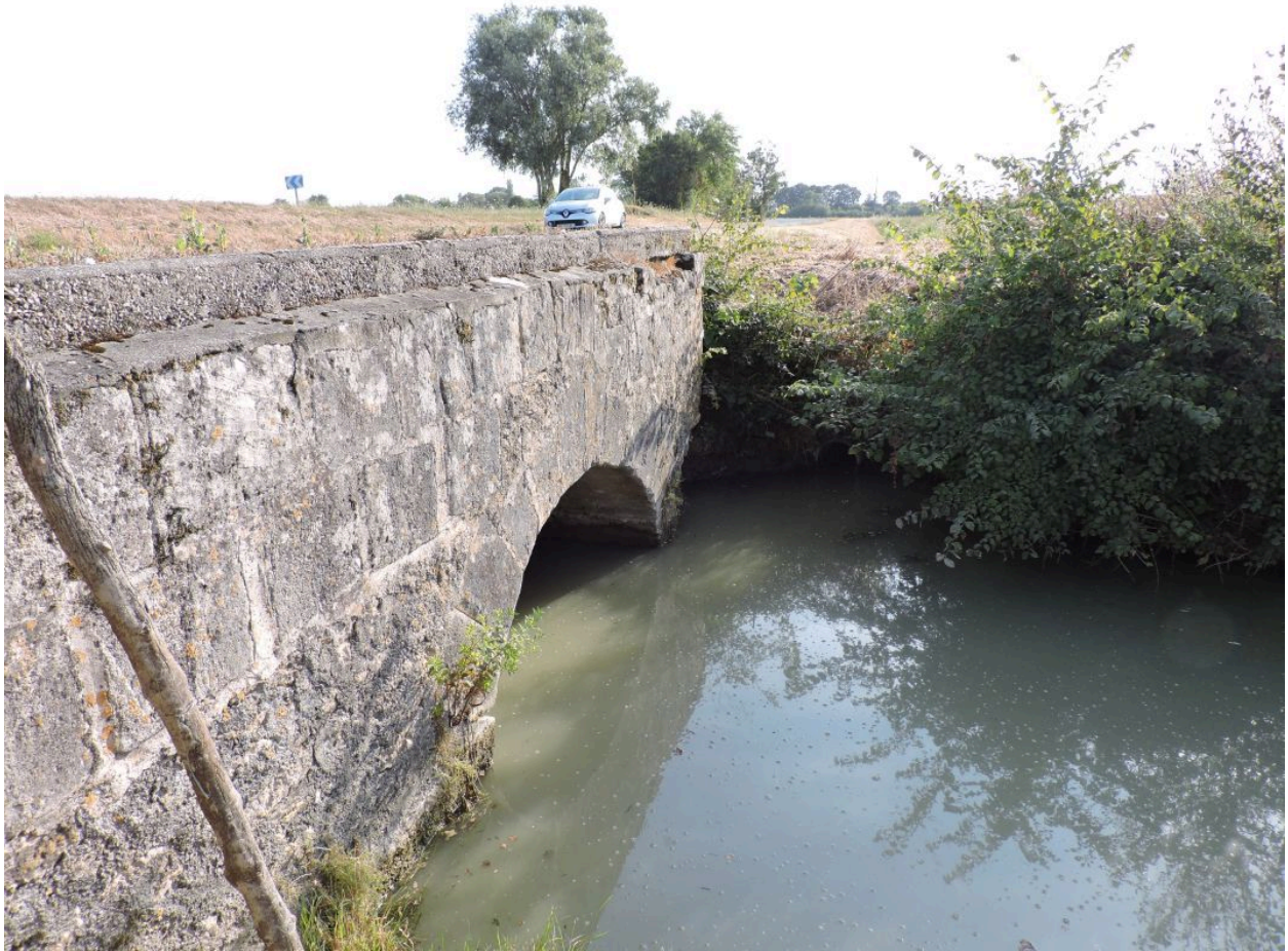
Le pont côté aval, vu depuis le sud-ouest.
