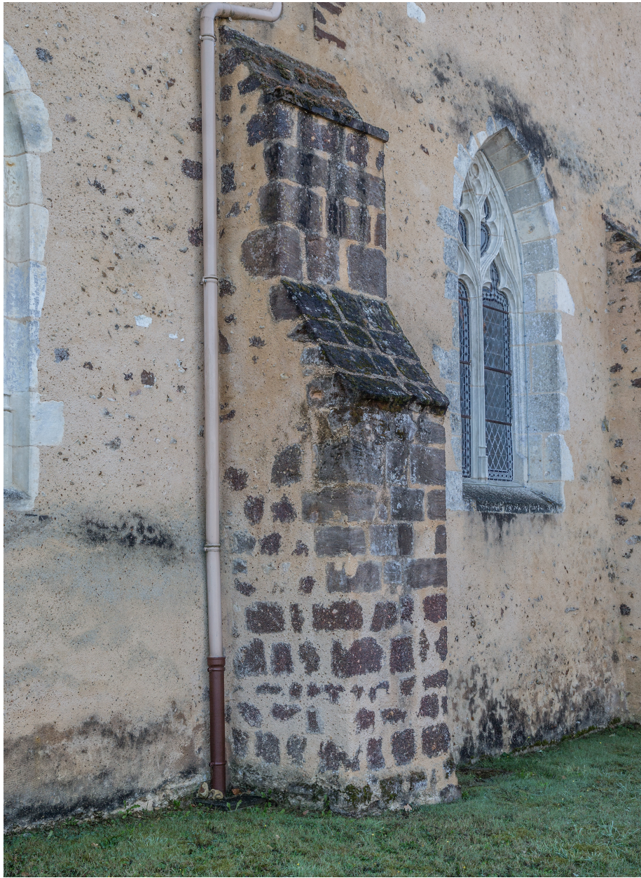
Un contrefort du bras nord du transept.
