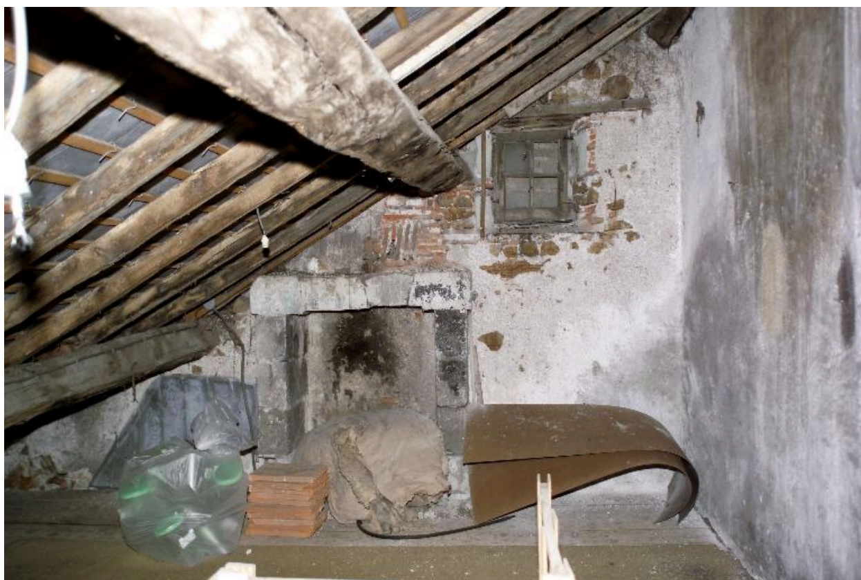
Le niveau du comble, la cheminée située au-dessus de l'escalier.
